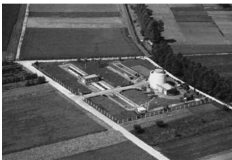
Die erste Kläranlage im Baselbiet am Marchbach in Therwil (Foto 1965)
