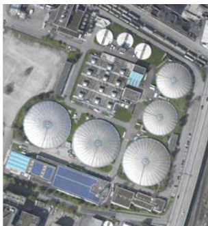
ARA Kleinhüningen, (Google Maps), 1984 heute bereits überholt und Nachfolgeprojekt in Planung
