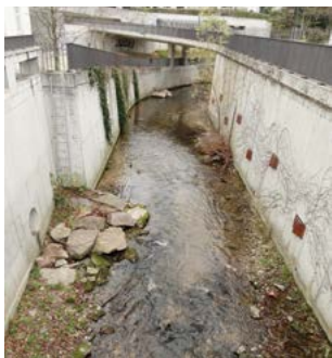
Neuerlegung des Birsigbettes im Zug der Umgestaltung des Schlosses Binningen
