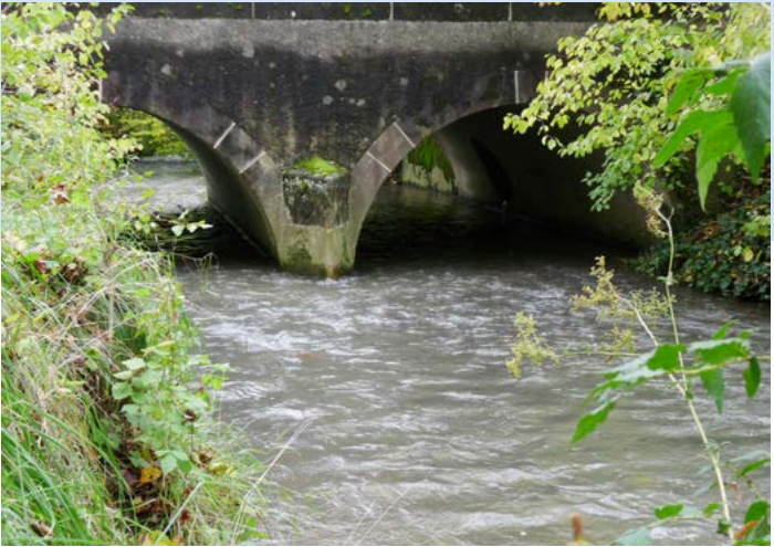
Biel-Benken Birsig bei der Brücke Kirchgasse
